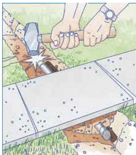
Pour le passage sous les dalles ou les allées, utiliser un marteau pour faire passer le tube galvanisé dont les 2 extrémités ont été obturées.
